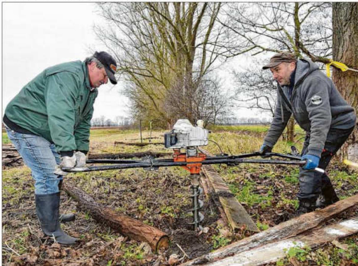
Harte Arbeit: Klaus-Peter Bielecke und Klaus Michalek (r.) vom Landschaftsförderverein packten mit an und bohrten die Löcher für die Zaunposten. Nach sechs Stunden Arbeit stand der neue Zaun, der später die jung gesetzten Pflanzen schützen soll. Foto: Inez Bandyol
